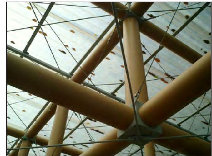
Voorbeeld constructie: Singapore biennale pavilion. Shigeru Ban. Constructie van kartonnen kokers, verbinding van staal.
