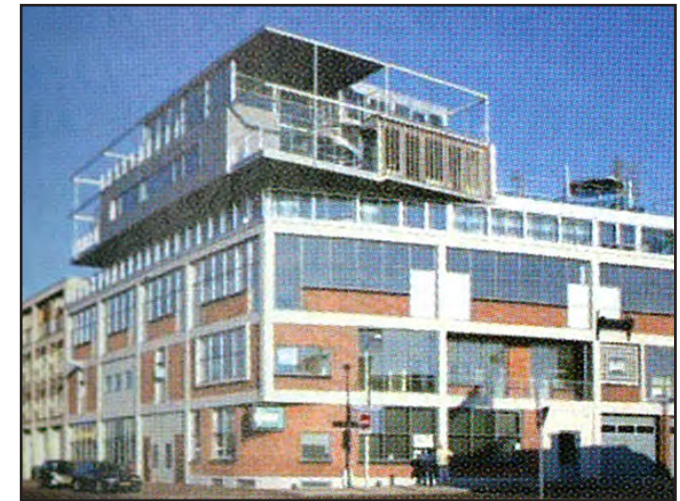
Voorbeeld constructie: Nautilus, Ysvis, Scheveningen. Archipel Ontwerpers. Constructie maakt optoppen mogelijk.
